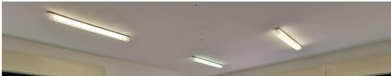
Particolare delle plafoniere con lampade fluorescenti tubolari in una delle aule
