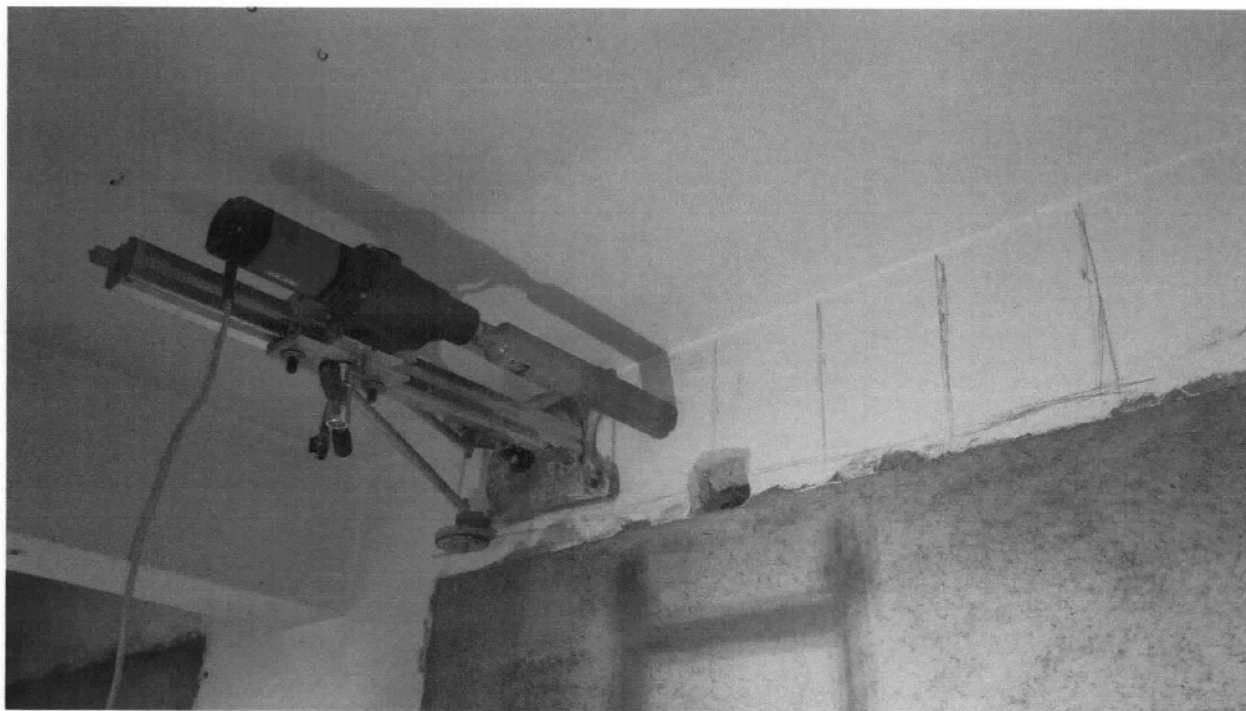
Figura 17 - Estrazione di carota di calcestruzzo indurito da trave TP33-34 (primo impalcato)
