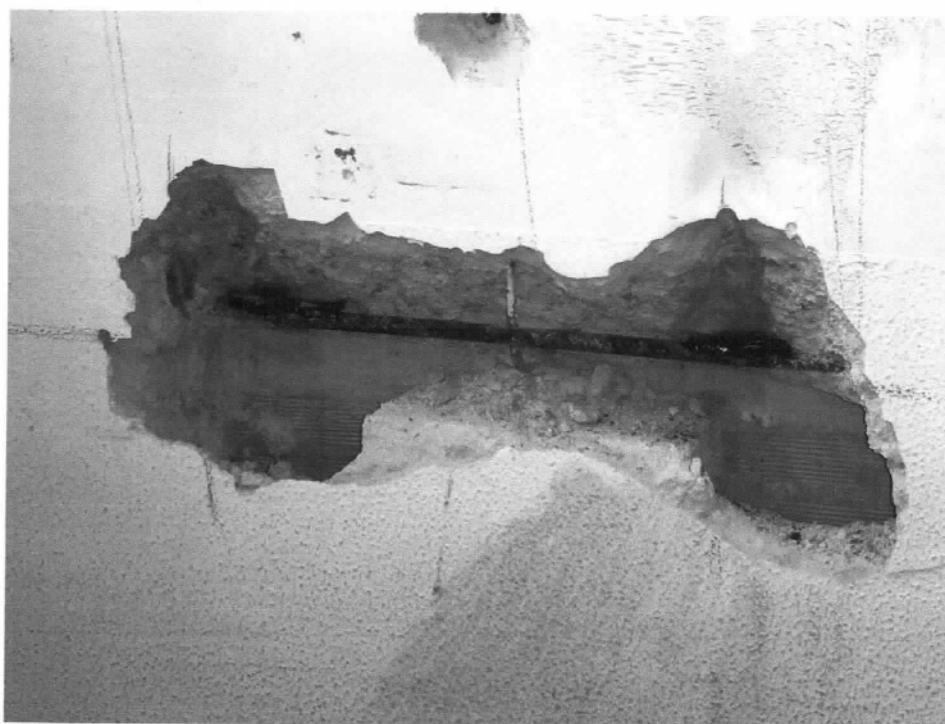
Figura 34 - Estrazione della barra di armatura FTP 13-14 dalla trave TP13-14
